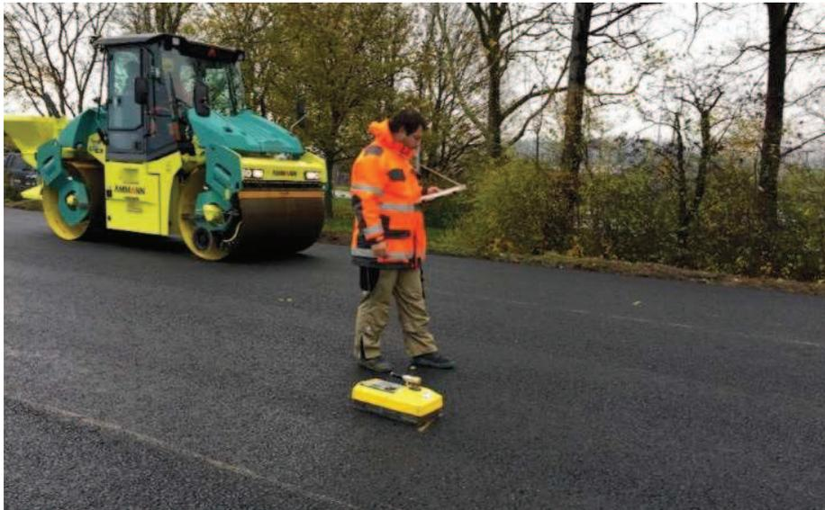
Abbildung 7: Troxlersondenmessung
